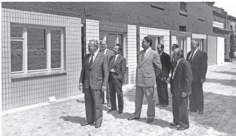
Керамічні панелі Подільського заводу стінових матеріалів і конструкцій СМІК. 1961 р.
